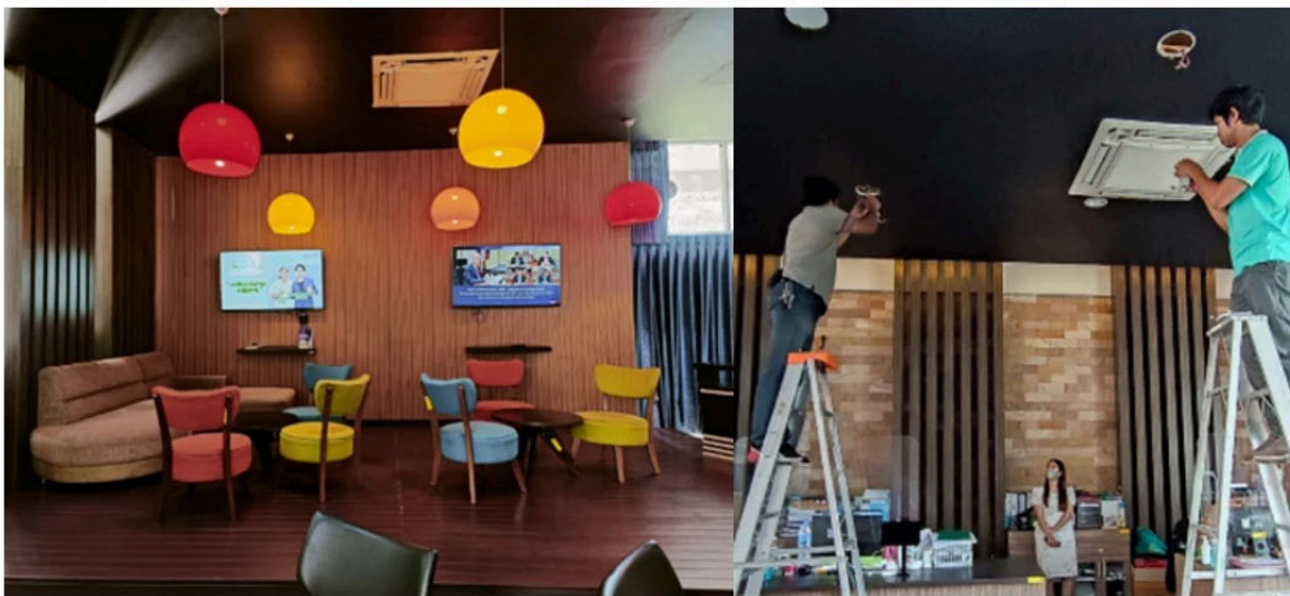
ภาพที่ 49 ห้อง Information ก่อนการปรับปรุง (รูปภาพด้านบน) หลังการปรับปรุง (รูปภาพด้านล่าง)
