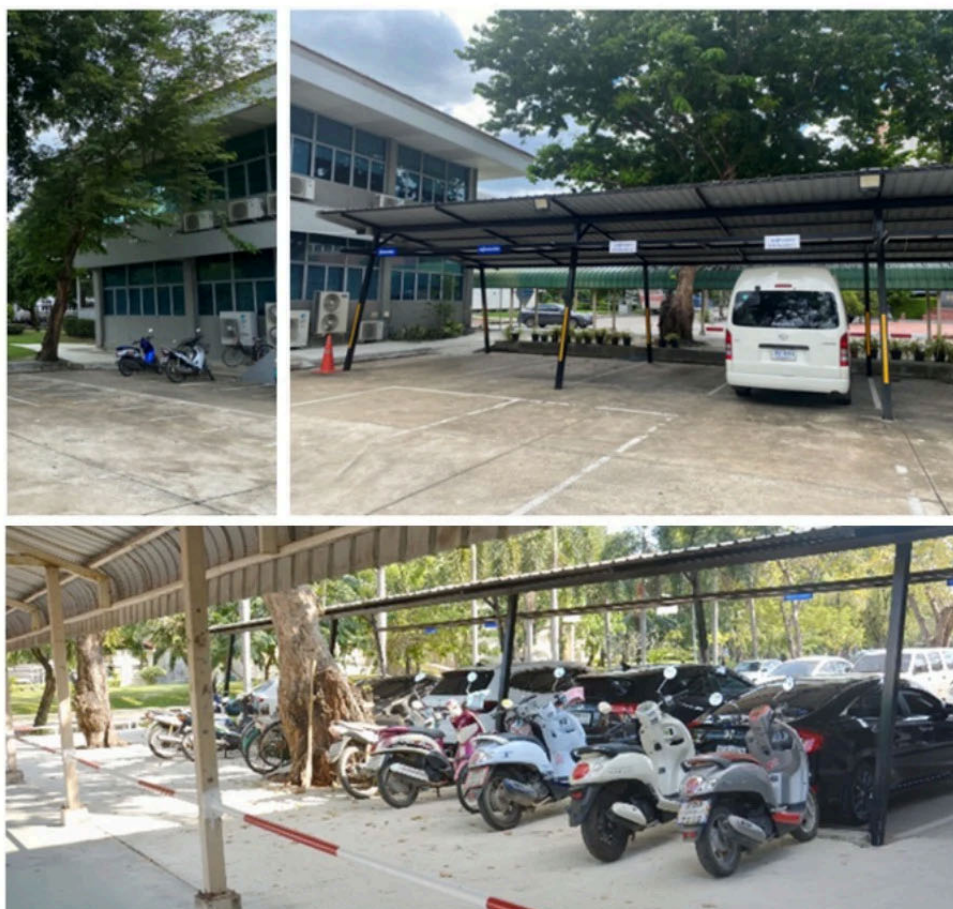
ภาพที่ 44 ลานจอดรถ ก่อนการปรับปรุง (รูปภาพด้านบน) หลังการปรับปรุง (รูปภาพด้านล่าง)
