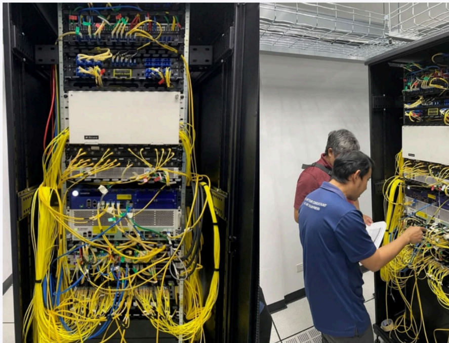
ภาพที่ 35 กิจกรรมการติดตั้งระบบ Firewall
